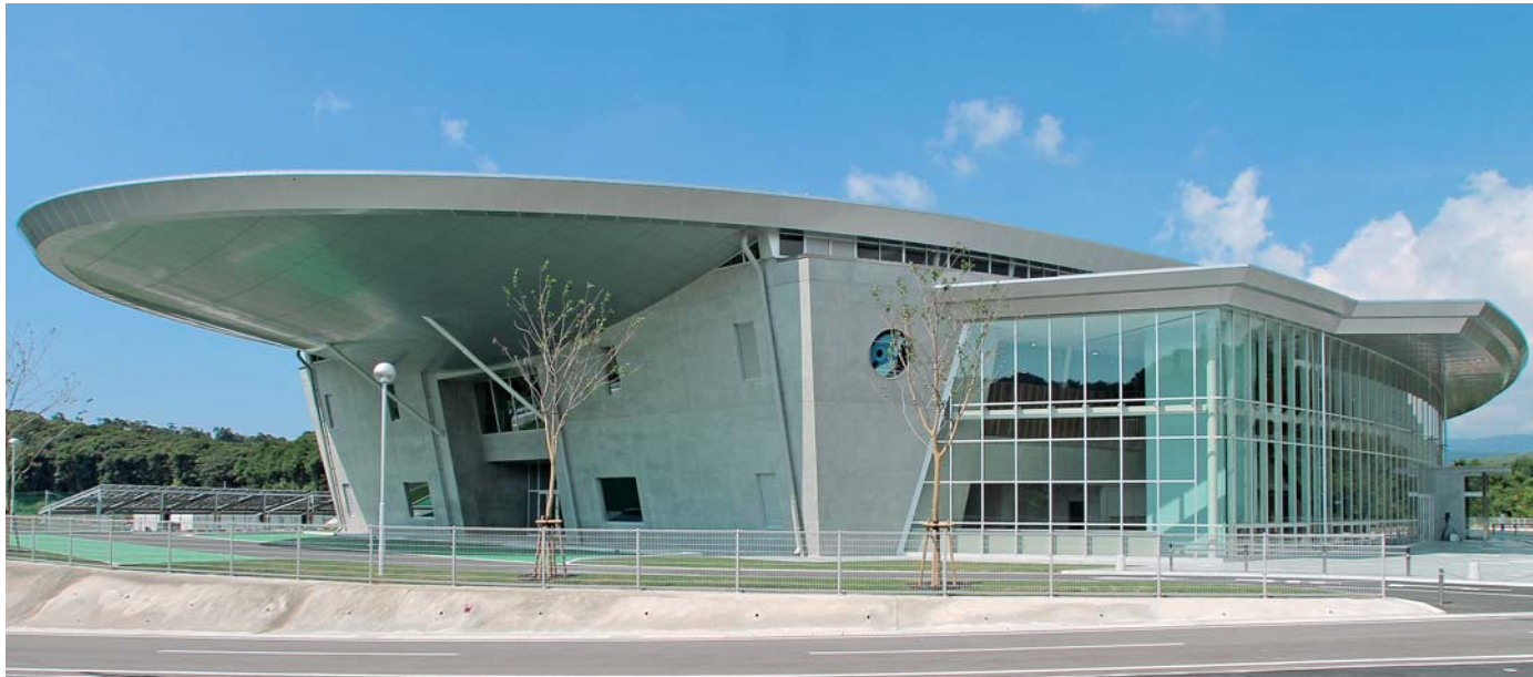
地上部から見る地場特産の「マグロ」をモチーフにした建物全景
